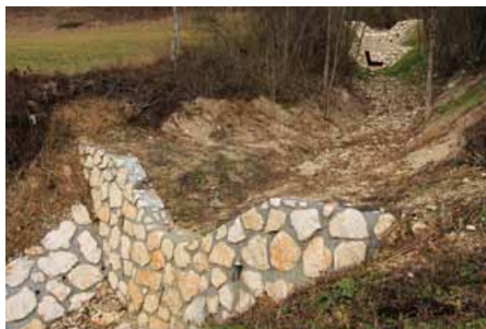
Slika 2: Veriga pregrad na strmem pobočju
